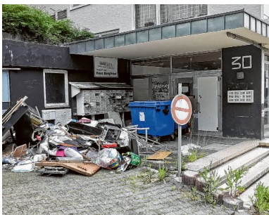
Müll liegt vor dem geräumten Haus „Bergfried“.
